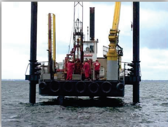
EGS CME 550 on Spud Barge
